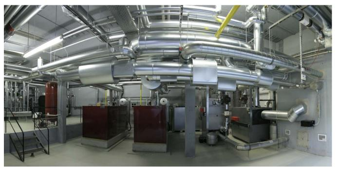
Beim Bau der Heizzentrale hat sich die hessenEnergie für zwei BHKW entschieden. Die Regelung sorgt dafür, dass diese vorrangig zur Wärmeerzeugung eingesetzt werden. Dabei können die BHKW nacheinander zu- bzw. abgeschaltet werden, um den Bedarf an Wärme optimal abzudecken. Es ist das Ziel eine 90% Deckung der Nutzwärme aus Kraft-Wärme-Kopplung zu erlangen.
