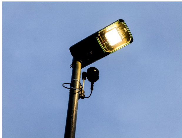
Smarte Straßenleuchte mit Kamerasystem
