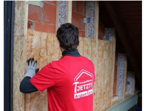
Abbildung 5: Eindrücken der Dämmstoffmatten. © PHI/Zeller
