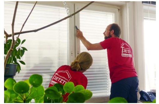
Abbildung 23: Aufgeklebte Isolierfolie andrücken. © Passivhaus Institut
