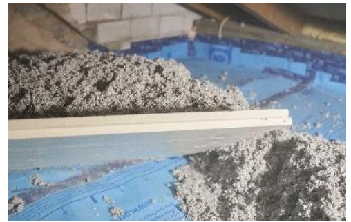
Abbildung 20: Aufgelockerte Zellulose an Ort und Stelle schieben. © Passivhaus Institut
