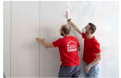
Abbildung 9: Beim Setzen der Dämmstoffplatten. © Passivhaus Institut
