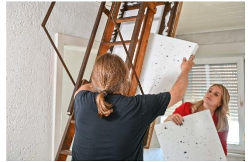
Abbildung 19: Anbringen der zugeschnittenen Dämmstoffplatten. © LEA-Hessen/Rundel
