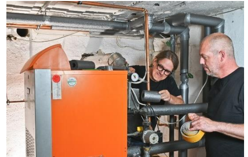
Abbildung 33: Dämmen warmer Rohrleitungen mit PE-Schalen. © LES-Hessen/Rundel
