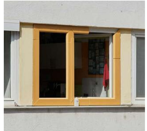
Abbildung 27: Profilierte Dämmschalen probefahrig eingesetzt. © Passivhaus Institut
