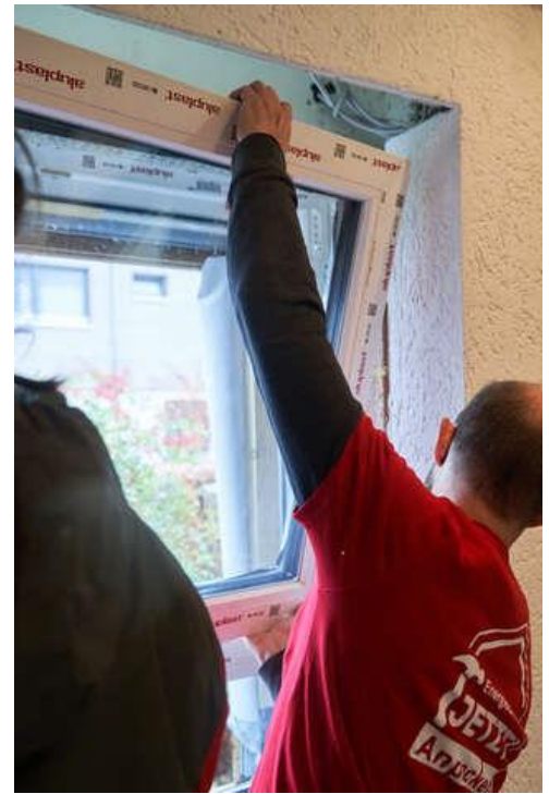
Abbildung 31: Einsetzen des neuen Fensterflügels. © Passivhaus Institut
