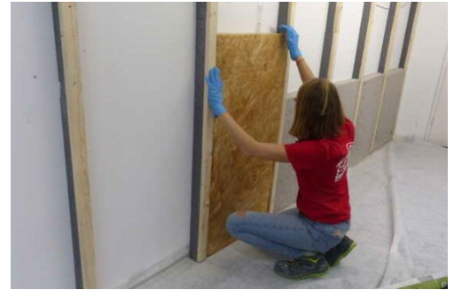
Abbildung 12: Eindrücken des Dämmstoffes in die Unterkonstruktion aus Holz-EPS-Verbundträgern © Passivhaus Institut
