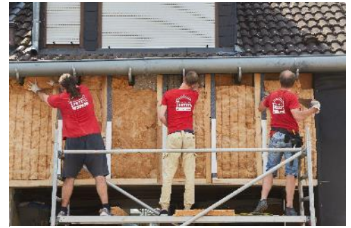
Abbildung 6: Einbringen des Dämmstoffes. © Passivhaus Institut
