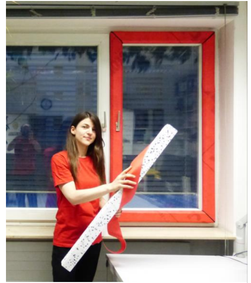
Abbildung 25: Der fertig gedämmte Fensterrahmen. © Passivhaus Institut
