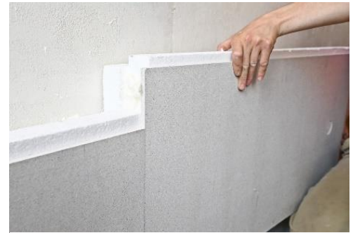
Abbildung 8: Ankleben der Dämmstoffplatten. © LEA/Rundel
