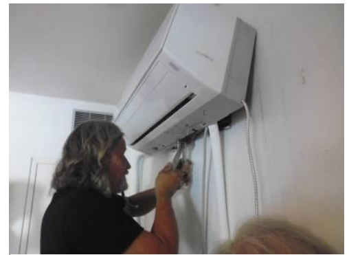
Abbildung 37: Montage der Inneneinheit eines Splitgerätes. © Passivhaus Institut
