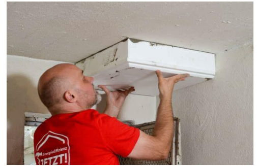
Abbildung 1: Andrücken einer EPS-Platte an die Kellerdecke. Foto: © LEA/Rundel
