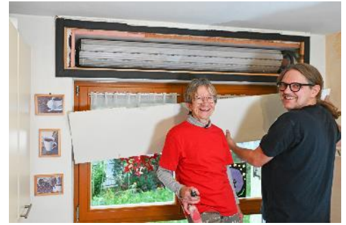
Abbildung 29: Verschließen des gedämmten Kastens. © LEA-Hessen/Rundel
