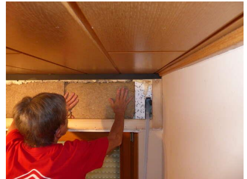
Abbildung 30: Dämmung eindrücken. © Passivhaus Institut
