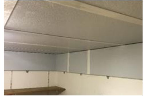
Abbildung 2: Mit PU-Platten gedämmte Kellerdecke inkl. Begleitdämmung. Foto: © PHI/Arnautu
