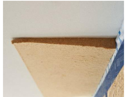
Abbildung 13: Gekaufter Dämmkeil aus Holzweichfaserplatten © Passivhaus Institut
