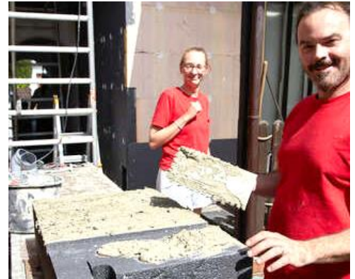
Abbildung 4: WDVS: Kleber aufbringen. © Passivhaus Institut
