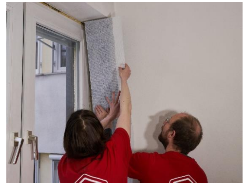
Abbildung 26: Einkleben der Fensterlaibungsdämmung. © Passivhaus Institut
