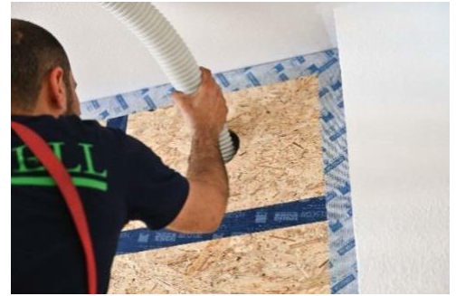
Abbildung 11: Ausblasen des Hohlraums mit Zelluloseflocken durch die Fachfirma © LEA/Rundel
