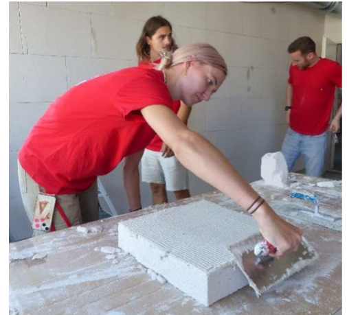
Abbildung 10: Mineralschaumplatten mit Kalkklee- bemörtel einstreichen © Passivhaus Institut
